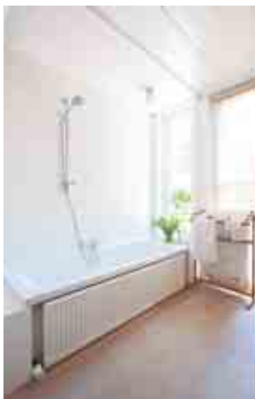
De radiator staat tegen de zijkant van het bad. Dat bespaart plaats en het is nog lekker warm ook.
